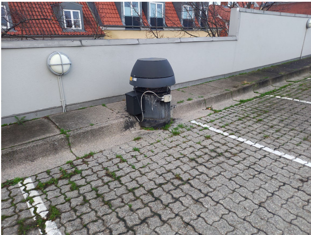
Figur 16 Afkast fra erhvervskøkken
